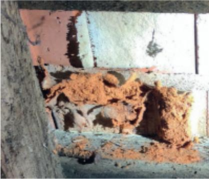
Die Ziegel sind stark korrodiert und fallen daher vom Dach.
