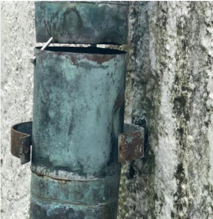
Nicht mehr ganz dicht sind die Dachrinnen. Feuchtigkeit schädigt die Substanz.
